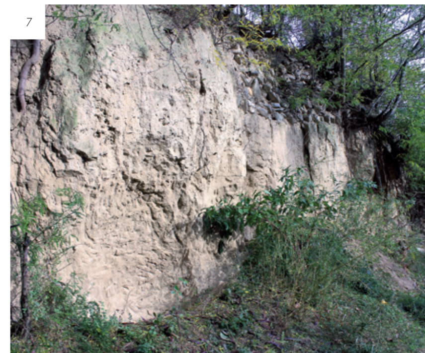
7 COLȚUL DE S-V AL CASTRULUI GATA SĂ SE PRĂBUȘEASCĂ, CU URMĂTOAREA ALUNECARE DE TEREN.
